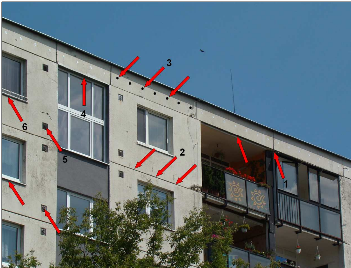
Obr. 5 Najčastejšie miesta kde netopiere nachádzajú vhodné štrbiny a dutiny: 1 – pod plechom nad balkónom, vliezajú tu do vnútra panelov, 2 – štrbiny medzi panelmi, 3 – vetracie otvory v atike, 4 – štrbina nad schodiskom, 5 – vetračky do kuchyne, 6 – pod parapetnými doskami.
