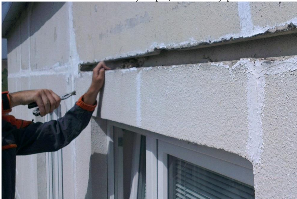
Foto 1: Náhodná kontrola dilatačných špár, ktoré boli vyšpárované v minulosti
